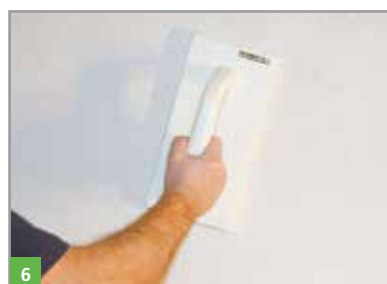
6 Afwerken van de dunpleister BOTAMENT® RENOVATION FP
