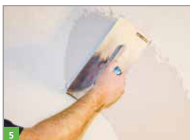
5 Optioneel, aanbrengen van de dunpleister BOTAMENT® RENOVATION FP
