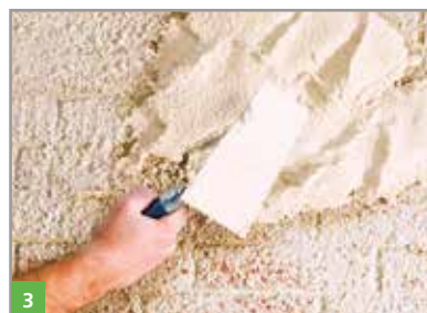
3 Aanbrengen van het speciaal-mortel voor vocht BOTAMENT® RENOVATION FSP
