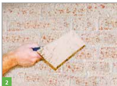
2 Netvormig aanbrengen van de voorspuitmortel/hechtmortel BOTAMENT® RENOVATION VSM
