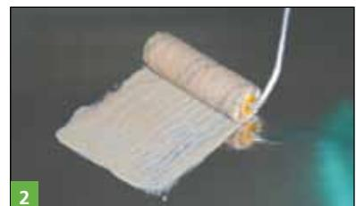
2 Application au rouleau du primaire BOTAMENT® Multiprimer R 20 sur une tôle d'acier nettoyée.
