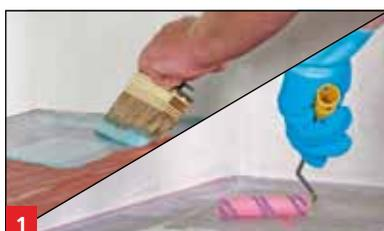
1 Primarisation du sol en bois laqué verni avec BOTAMENT® D 15, alternative pour une chape fissurée avec BOTAMENT® D 11.
