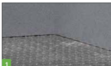
Le support métallique doit être exempt de décoffrage, parfaitement stable et non courbe. Une primarisation n'est pas requise.
