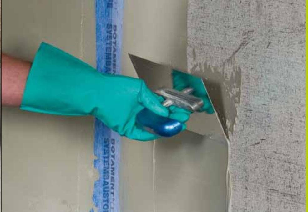
Le primaire BOTAMENT® R 20 Multiprimer convient à de nombreuses applications. Il permet non seulement de traiter le béton lisse à grains fins, mais aussi de protéger efficacement les chapes à base de sulfate de calcium contre l'humidité résiduelle. Il est inutile de sabler ce primaire puisqu'il contient déjà du sable siliceux.
