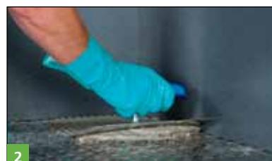
Préparation de BOTAMENT® EF 500/EK 500 sur le support métallique.
