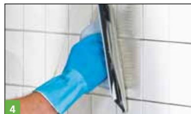
Jointoiment avec **MULTIFUGE® Fine** ou **MULTIFUGE® FineSpeed**.
