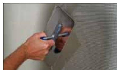
Alternative pour les panneaux prêts à carrelers: au niveau des angles de sols des panneaux, une application de tissu de BOTAMENT® GS 98 doit être effectuée, afin d'éviter la formation de fissures.
