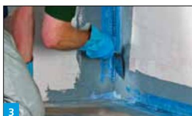
3 Application des bandes d'étanchéité sanitaires **BOTAMENT® SB 78** et des angles d'intérieur et d'extérieur **BOTAMENT® SB 78**.
