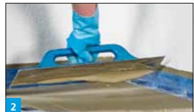
2 Application de BOTAMENT® M 21 F / BOTAMENT® M 10 Speed après la formation de la bande d'étanchéité sanitaire et de l'angle d'intérieur BOTAMENT® SB 78.
