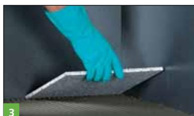
Application des carreaux dans BOTAMENT® EF 500/EK 500. Une grande spatule dentelée correspondante doit être choisie, afin d'obtenir un bon mouillage.
