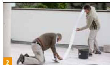
La natte drainante est appliquée selon les instructions du fabricant. On applique le mortier colle BOTAMENT® M 10 Speed à l'aide d'une spatule crantée de 6 x 6 mm, puis on appuie sur la natte drainante à l'aide d'une taloche pour l'encastrer dans le lit de colle.
