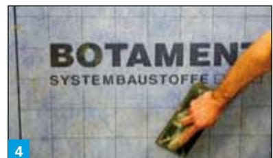
4 Application des bandes d'étanchéité et de désolidarisation BOTAMENT® sur mur.
