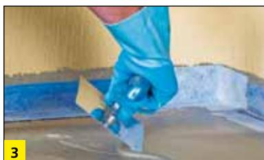
3 Mise en œuvre de la bande d'étanchéité sanitaire et des angles d'intérieur BOTAMENT® SB 78, dans BOTAMENT® MD 2 The Blue 1 ou BOTAMENT® MD 1 Speed.
