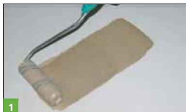
1 Application au rouleau du primaire BOTAMENT® Multiprimer R 20 sur une chape sulfate de calcium à protéger contre l'humidité résiduelle.
