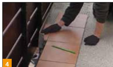
4 On applique la colle BOTAMENT® BTK 200 Terrachamp sur le mortier drainant à l'aide d'une taloche crantée au format adapté.
