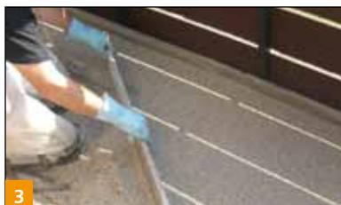
3 Après la mise en place des bandes d'isolation périphériques, on peut appliquer le mortier drainant en respectant une épaisseur minimale de 2 cm, l'égaliser et le lisser.
