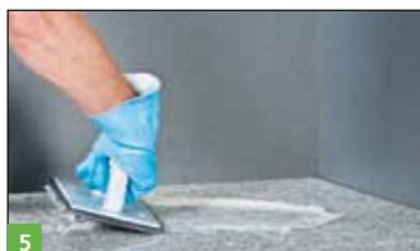
Jointoiement avec MULTIFUGE® Fine ou MULTIFUGE® FineSpeed.
