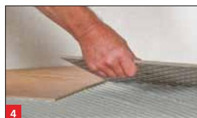
4 Pose des carreaux sur la plaque de découpage avec MULTISTONE®.
