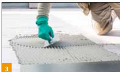
On applique la colle bi-composant BOTAMENT® BTK 200 Terrachamp à l'aide d'une spatule crantée adaptée aux dimensions du revêtement. Pas de double encollage nécessaire !
