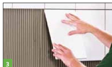
3 Pose des carreaux des carreaux dans le lit de colle de MULTILIGHT® ou MULTISTONE®.
