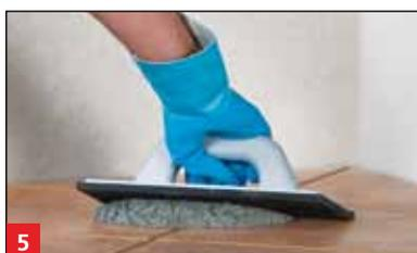
5 Jointoiement du revêtement avec MULTIFUGE®Fine ou MULTIFUGE®FineSpeed.
