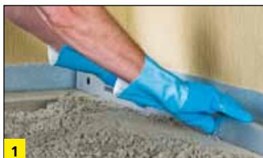
1 Mise en œuvre de la forme de pente avec 2 % minimum, fabriquée par BOTAMENT® M 100.
