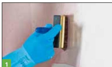
Primairement du béton avec le primaire pour supports absorbants à un composant **BOTAMENT® D 11**. Avant la primarisation, le béton doit être contrôlé sur des couches de mortier et des restes des huiles de décoffrage.
