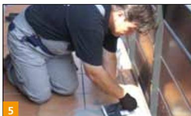
5 Une fois le revêtement sec, on applique le mortier joint BOTAMENT® BTF 200 Terrachamp à l'aide d'une taloche en caoutchouc puis on nettoie.
