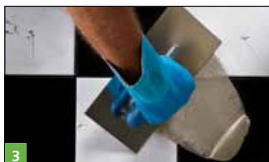
3 Réalisation d'un pont d'adhérence avec l'étanchéité flexible mono-composante BOTAMENT® MD 1 Speed sur un revêtement de terrasse usagé.
