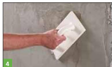
4 Application du mortier BOTAMENT® M 90 à l'aide d'une taloche rugueuse.
