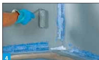
4 Déroulement de l'imperméabilisation sous carrelage **BOTAMENT® DF 9**, à réaliser en double couche (alternative **BOTAMENT® MD 1 Speed**, voir le tableau de la page 54).
