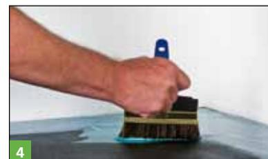
4 Traitement d'un support en asphalte coulé, usagé et non sablé, avec le primaire BOTAMENT® D 15.
