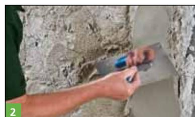
2 Ragréage des murs inégaux à l'aide du mortier BOTAMENT® M 100 en couches de 50 mm d'épaisseur maxi.
