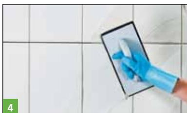
4 Jointoiment avec MULTIFUGE® Fine ou MULTIFUGE® FineSpeed.
