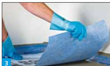
3 Pose de la natte d'étanchéité et de désolidarisation dans BOTAMENT® M 21 F / BOTAMENT® M 10 Speed avec 5 cm de chevauchement.
