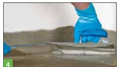
4 Application (en deux couches) de l'étanchéité BOTAMENT® MD 1 Speed intégrant la bande d'étanchéité BOTAMENT® SB 78 et l'angle intérieur.
