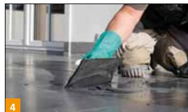
Une taloche en caoutchouc permet d'appliquer facilement le mortier joint BOTAMENT® BTF 200 Terrachamp. Le joint ne brûle pas sous l'effet de la chaleur et résiste à d'innombrables lavages.
