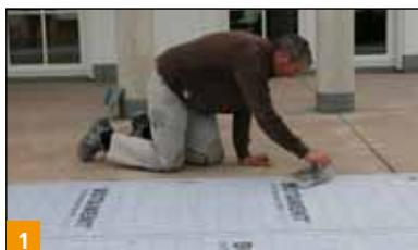
Après l'application au rouleau et le séchage du primaire BOTAMENT® D 11, on colle le rouleau d'étanchéité et de désolidarisation BOTAMENT AE avec le mortier colle BOTAMENT® M 10 Speed qu'on applique à l'aide d'une spatule crantée de 4 à 6 mm. Les jointures doivent se recouvrir dans le sens de l'écoulement.
